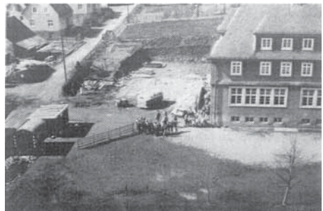
Blick vom Turm der Kirche auf Schulhof, Schule und einen Teil der Baustelle der neuen Schule
