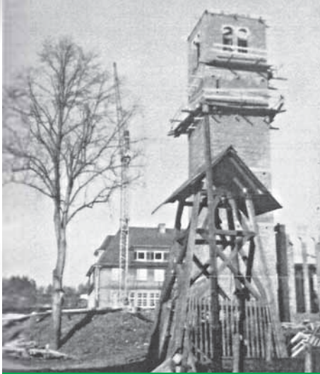
Alter und neuer Glockenturm - Vergangenheit und Zukunft. Rechts neben dem Turm des Dachstuhls beraubte Kirchenschiff, im Hintergrund die 1936 erbaute aber leider zu kleine Schule
