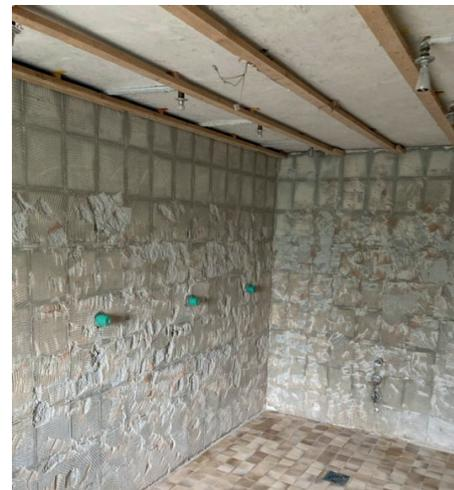
Duschkraum nach Abriss der alten Fliesen und Trocknung der Wände
